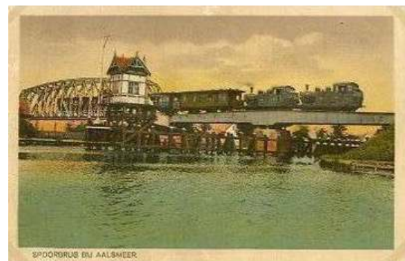
Afb. 10. Ook de aanleg van de spoorbrug Aalsmeer hoorde bij het grote project om de regio met treinen te ontsluiten.
